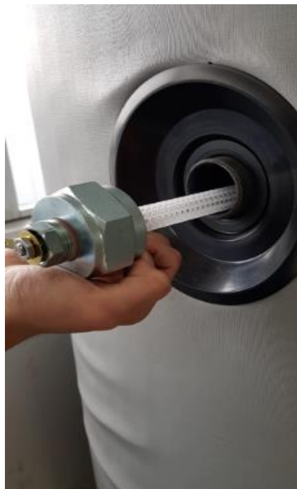
Conexión del ánodo de titanio.
