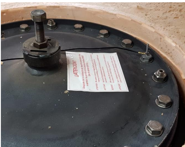
Conexión cable de masa Imagen 05
